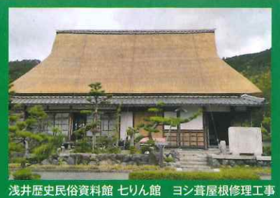
浅井歴史民俗資料館 セリん館 ヨシ葺屋根修理工事
