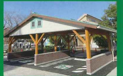
国道307号補助道路附属物新築工事
