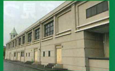
あづちマリエート改修工事
