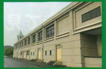
あづちマリエイト改修工事
