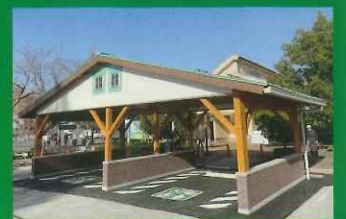
国道307号補助道路附属物新築工事
