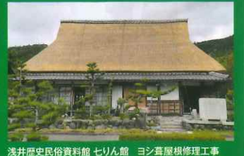
浅井歴史民俗資料館 セリル館 ヨシ草屋根修理工事
